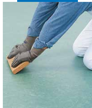
Massaggiatura del giunto di linoleum
