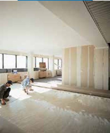
Stesura di Aquacol T per teli di grande dimensione
