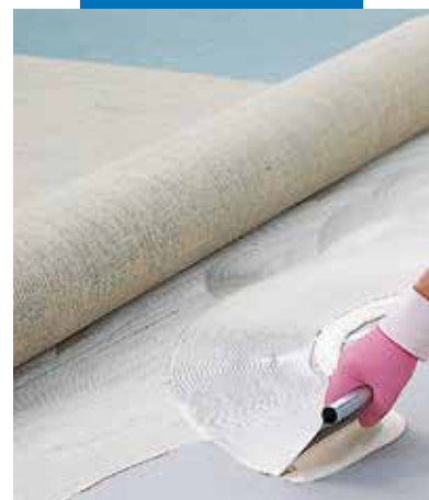
Stesura di Aquacol T per posa linoleum
